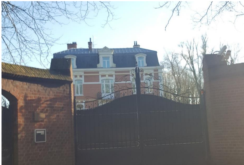
F- Maison remarquable
