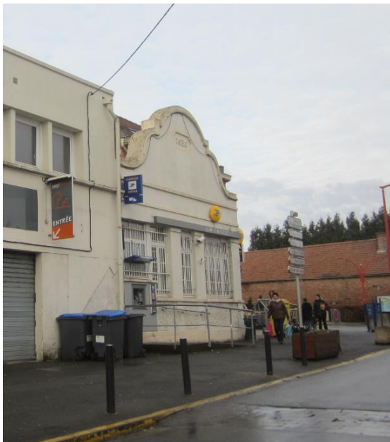
Photographie Urbycom : La Poste
