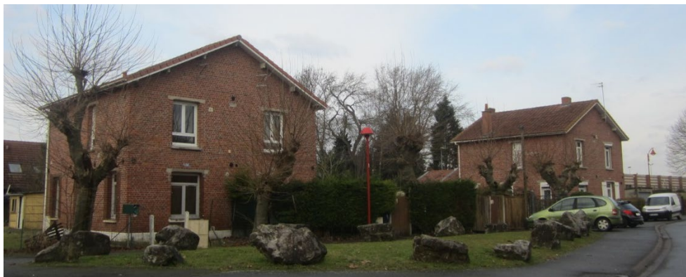
Les espaces publics larges et végétalisés autour des constructions
