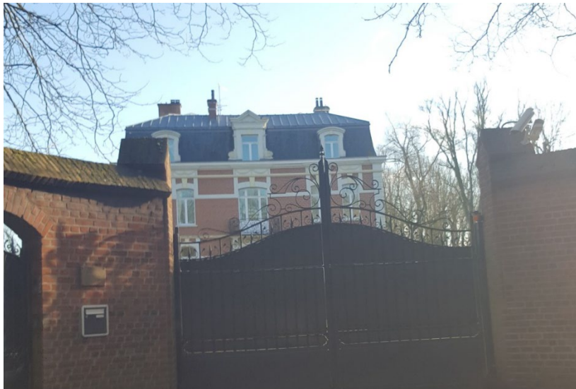
F- Maison remarquable
