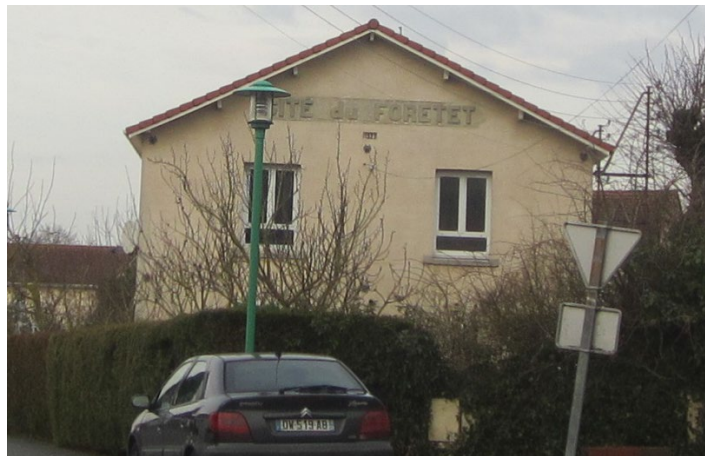
La maison d'appel de la cité du Foretet
