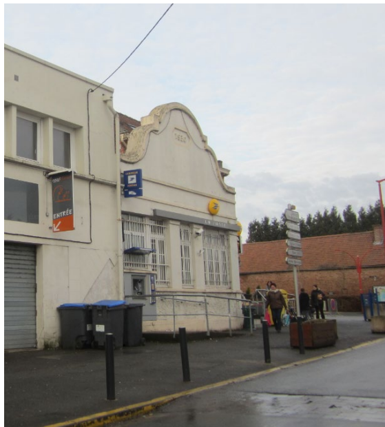
Photographie Urbycom : La Poste
